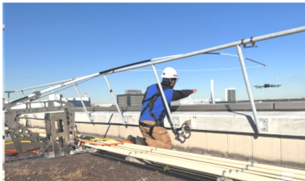
「ラインドローンシステム」屋上作業模様
