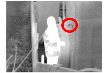
ガス漏れ検知試験
